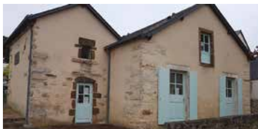
La Maison des Pompes.
